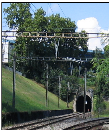
Cii-dessus : portail côté Salève, actuellement réservé au fret.
